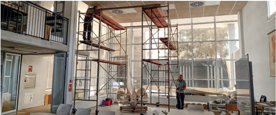
Imatge 10. Primeres passes de preparació per a la instal·lació a la traginada.
