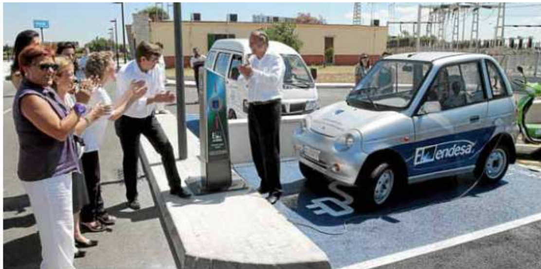
Francesc Antich i Aina Clavo visitaren el nou punt de proveïment elèctric, a la seu d'Endesa. Foto: PBota
